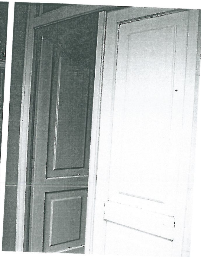
Fot. 46, 47. Kamienica z 1844 r., proj. A. Pluszyńskiego, ul. Józefa 16, Kraków. Stan zachowania – 2009 r. Oficyna tylna II. Stylizowana solarka drzwiowa z końca lat 80-tych, wejście do lokalu mieszkalnego z balkonu. Widoczne uproszczone profilowanie w płycinach drzwi, górna uchylna kwatera ze szprosem.
