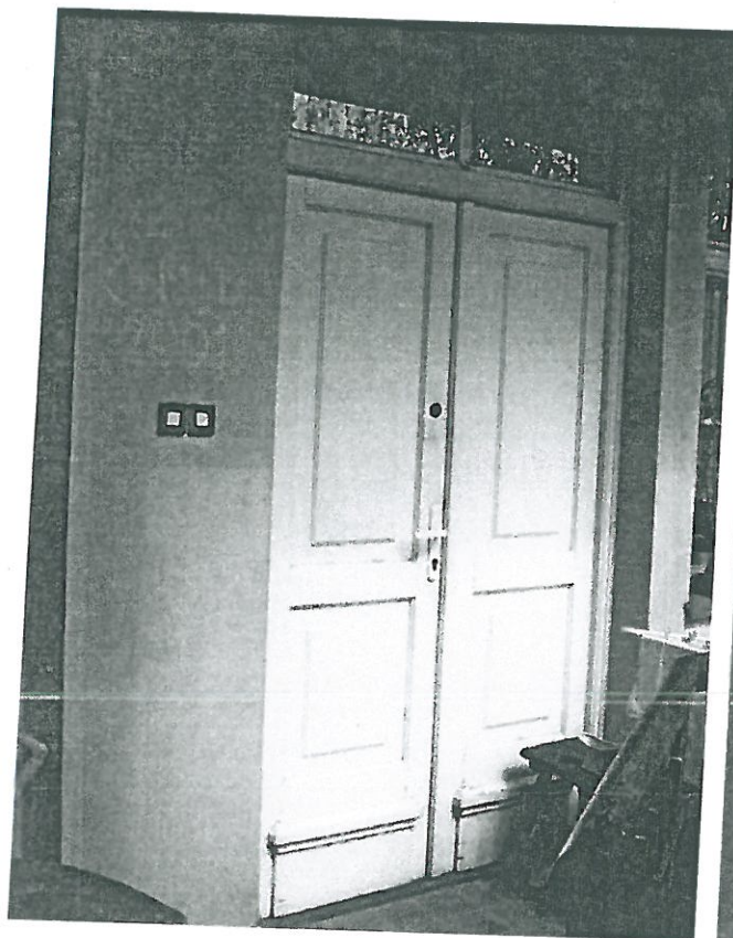
Fot. 46, 47. Kamienica z 1844 r., proj. A. Pluszyńskiego, ul. Józefa 16, Kraków. Stan zachowania – 2009 r. Oficyna tylna II. Stylizowana solarka drzwiowa z końca lat 80-tych, wejście do lokalu mieszkalnego z balkonu. Widoczne uproszczone profilowanie w płycinach drzwi, górna uchylna kwatera ze szprosem.
